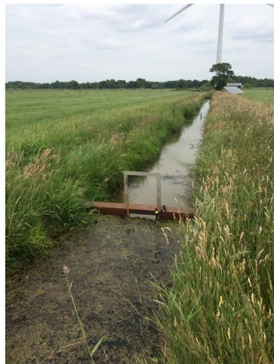
Das bestehende Wassermanagementsystem wird so optimiert, dass der Wasserstand in den Gräben stabil bleibt. Der Moorkörper dient als Schwamm, der sich mit Wasser füllt und somit nur geringe Mengen an Treibhausgasen freisetzt.
